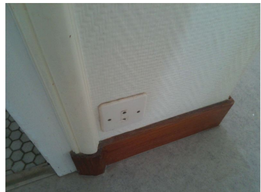
- Espace 1.4 (Chambre 1), Espace 1.5 (Chambre 2), Espace 1.6 (Chambre 3)
